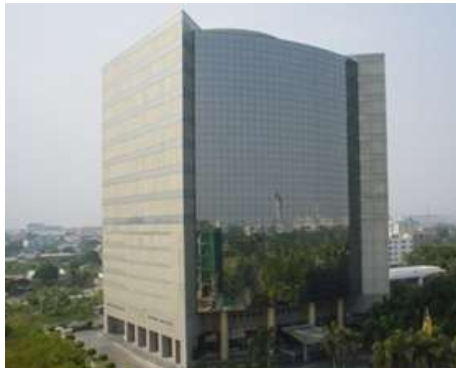
SAMAGGI TOWER - M.E.P. -
